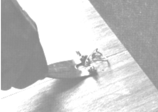
Fig. 7.2.a.5 Hand Grooving Tool
